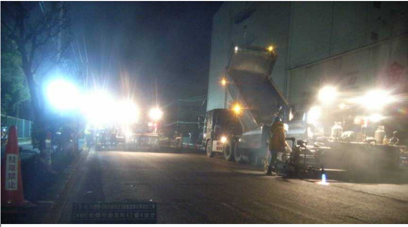
道路復旧作業は夜間も行われた（船橋市提供）
