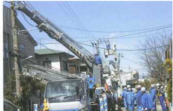
右 復旧工事のようす (浦安市提供)
