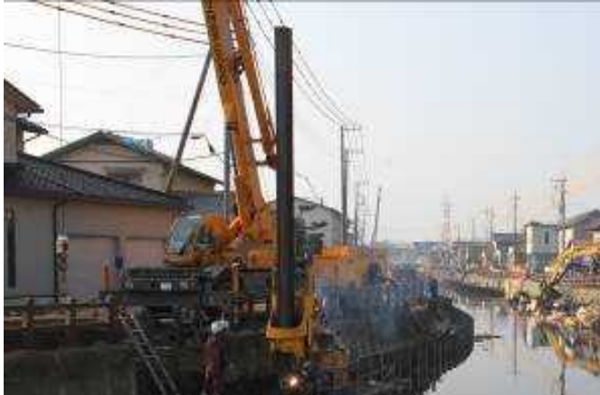
ひだり あのがわごがんやいたう ここうじ 左：小野川護岸矢板打ち込み工事のようす
