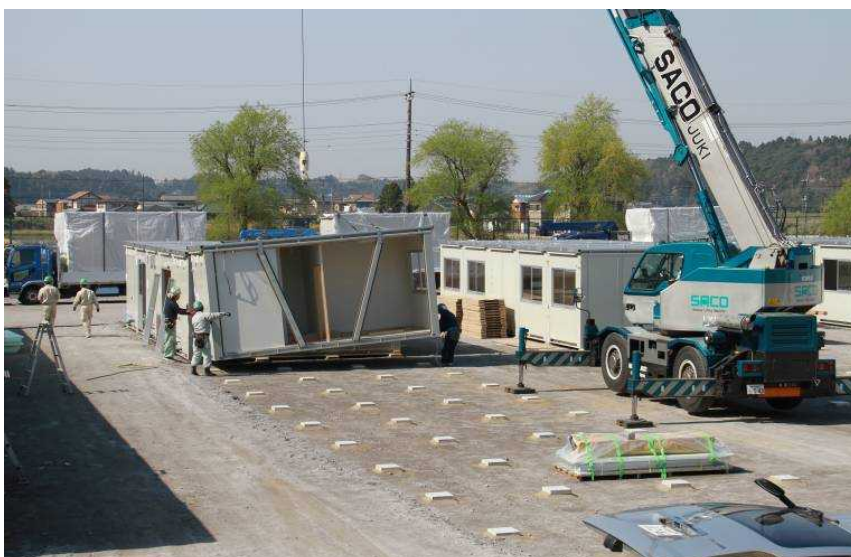
仮設住宅を建設するようす（香取市提供）
